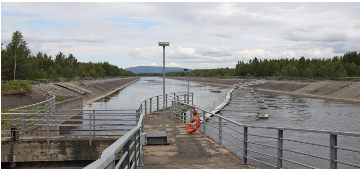
Bilde 3 Fra Strandfossen kraftverk i Elverum.
