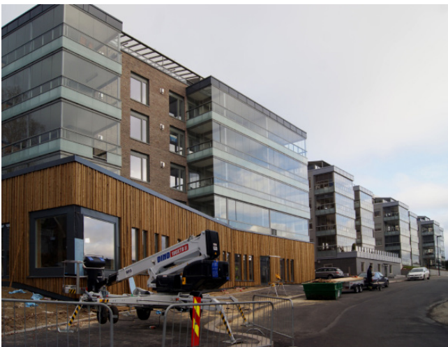
Bilde: Trolltoppen under utbygging, nær ferdigstilling.
